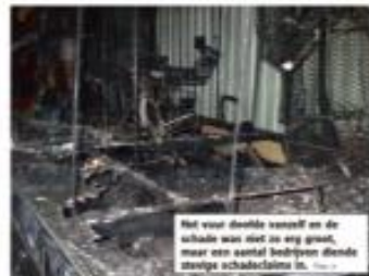
Het voor deeltje vanzelf en de schade was niet zo erg groot, maar een aantal bedrijven die de schade schadeloos. van der Weert
